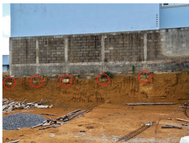
Imagem 03: Terreno que sofreu escavação, sendo visível as sapatas do muro vizinho expostas | Fonte: Acervo pessoal
